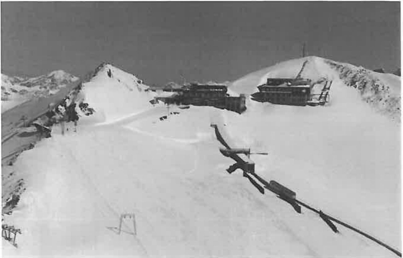
Bild oben: Das „alte“ Forschungsgebäude auf dem Weissfluhjoch auf 2670 m (Gebäude rechts).
