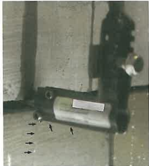
Bild 11 Einige Anker leiten das Wasser nach hinten.
