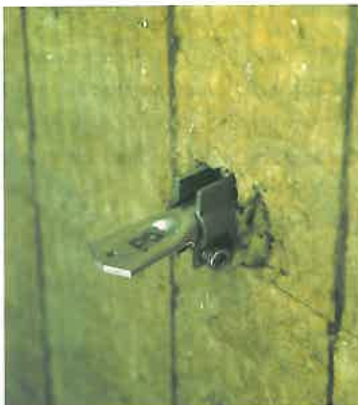
Bild 12 In Dämmstoffoberfläche gut eingepasster Anker.
